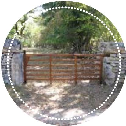
D'un côté une grande pierre verticale soutient une grosse pierre horizontale avec une encoche dessous qui permet de faire pivoter la barrière. De l'autre côté une grande pierre verticale porte des butées et trous où viennent s'enclencher la clède.
